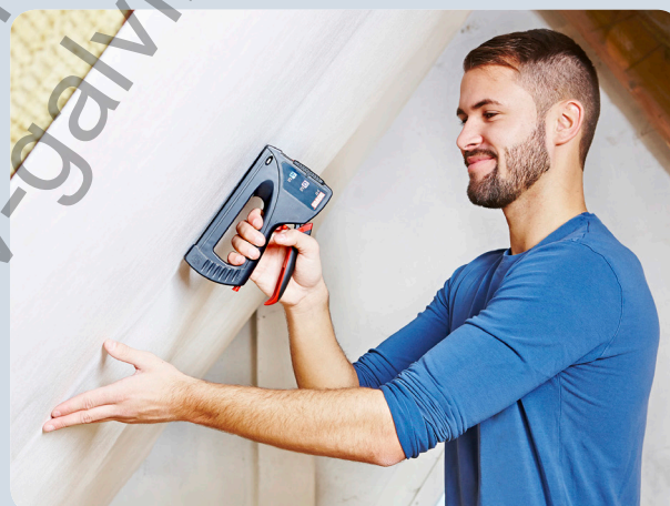
Folie beim Dachbodenausbau einfach befestigen.
